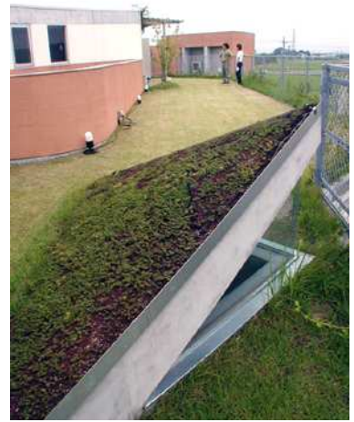
屋上庭園 / トップライト
